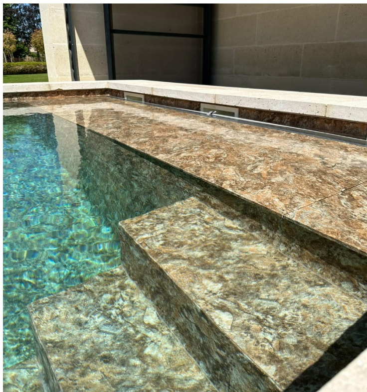
(Volet immergé camouflé dans l'escalier)
